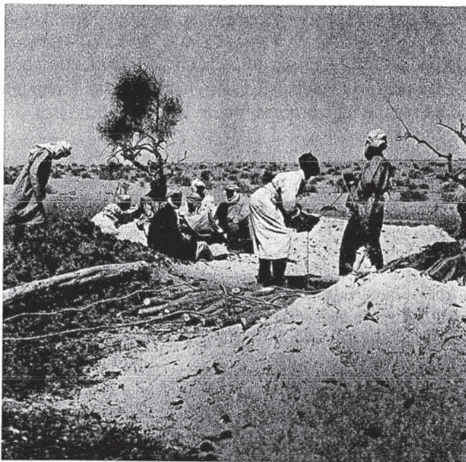
2. Creusement d'un nouveau puits
